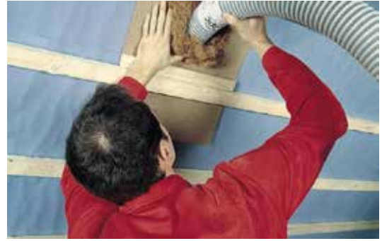
Figuur 122. Reductie warmtevraag: schilisolatie
